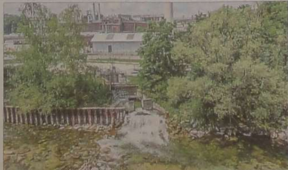
Über fünf Jahre dauerte das Genehmigungsverfahren für die „gehobene wasserrechtliche Einleitungs-Erlaubnis“ des Chemieparks Gendorf. - F. H. Heine
