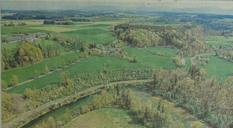
Milliardenschwer ist der Sanierungsstau bei den Brücken im bundesdeutschen Straßennetz. Umso unverständlicher ist in den Augen der „B 304 neu“-Gegner der Plan, eine dreispurige Brücke über das Naturidyll des Alzkniees – hier mit Blick auf Nock – zu bauen. – Foto: Unterhausler/luftbild-traunstein.de
