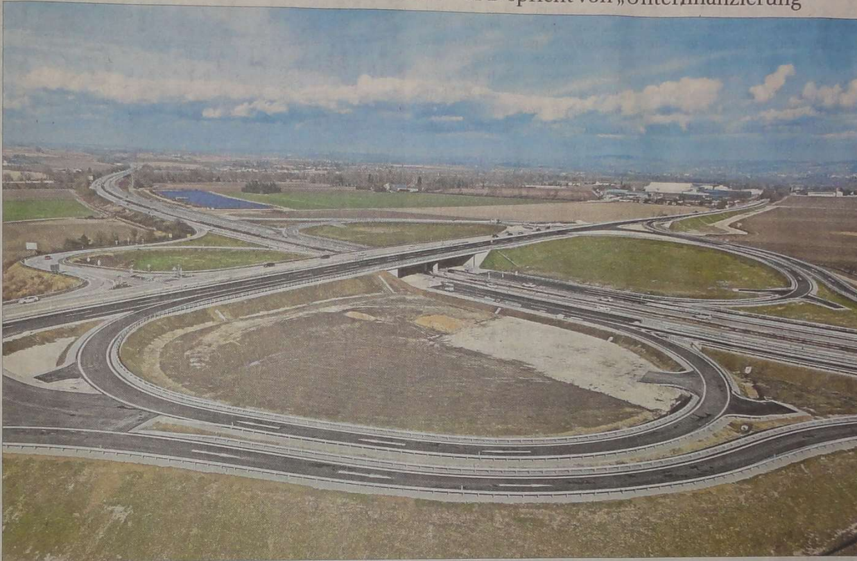
An der Anschlussstelle bei Pocking (Lkr. Passau) entsteht aktuell das Autobahndreieck, das künftig die A 3 mit der A 94 verbinden soll. Die Fertigstellung ist für 2026 geplant, doch sie könnte sich aufgrund der Finanzierungslücke verzögern. – Foto: Autobahn GmbH/Felix Bonn
