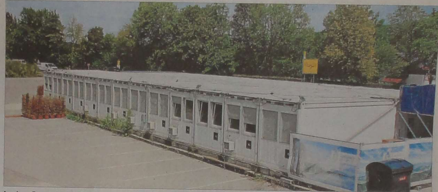
In den Containern am Abergertunnel in Altenmarkt ist nach ihrer Nutzung als Covid-19-Impfzentrum und später als Erstaufnahmezentrum für Geflüchtete nun die erste ukrainische Familie eingezogen. – Foto: Yannick Schmitt
