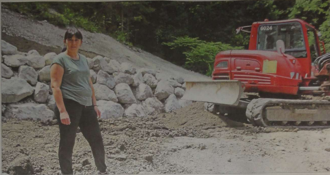
Eine hohe Mauer aus großen Steinen soll das Grundstück in Zukunft schützen.
