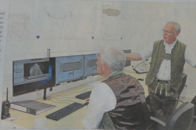
Wie eine „Schaltzentrale der Nato“, bezeichnete Baudirektor Christian Rehm den sogenannten Warterraum (Zentrale) des Aubertunnels. Die Schaltzentrale befindet sich im Betriebsgebäude. – Fotos: Rasch
