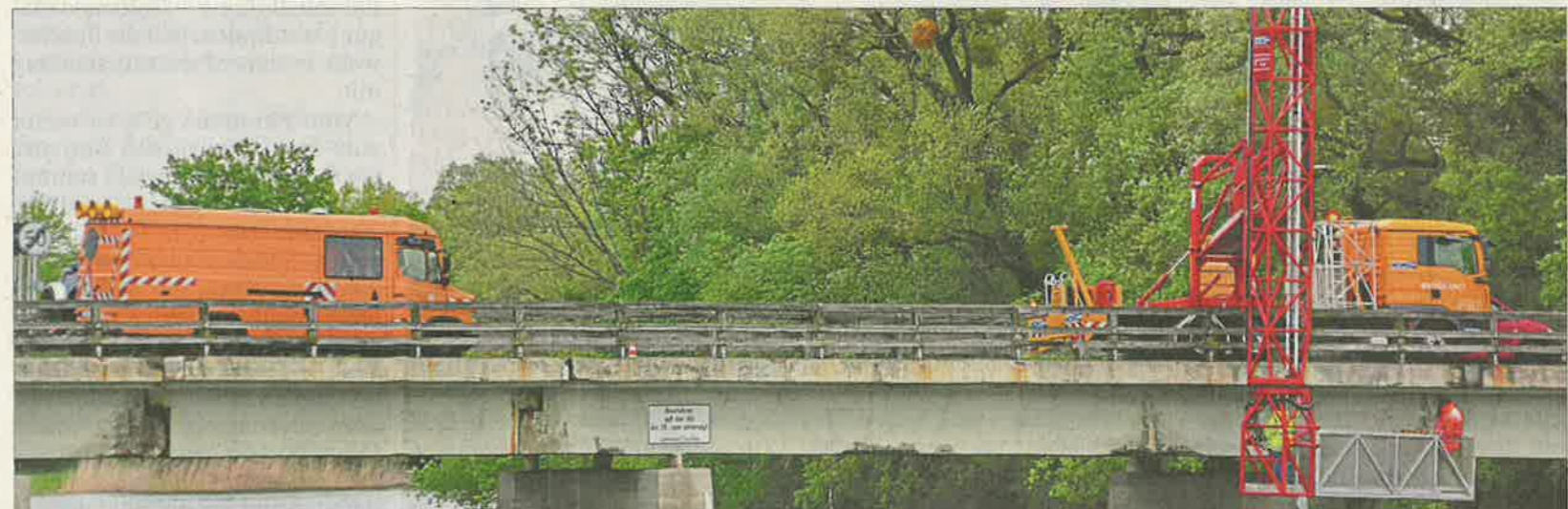
Derzeit ist die Alzbrücke halbseitig gesperrt. Es werden Vorarbeiten geleistet, damit das Monitoring-Gerät angebracht werden kann.
